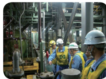
環境重点設備点検
